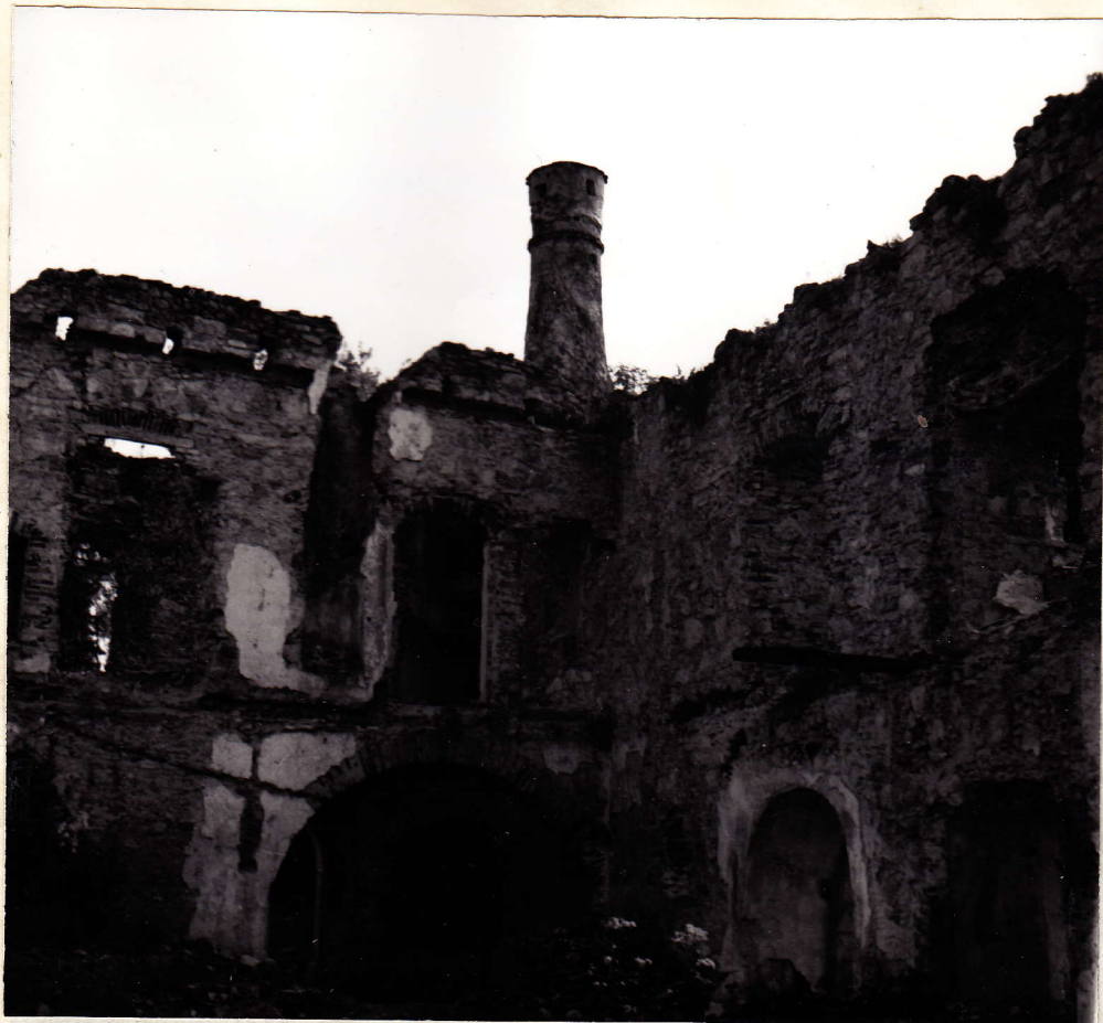
Unutrašnje dvo- rište, pogled prema jugozapad- nom uglu.
