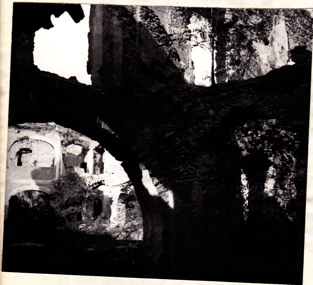
Unutrašnjost dvorca - oštećenja.
