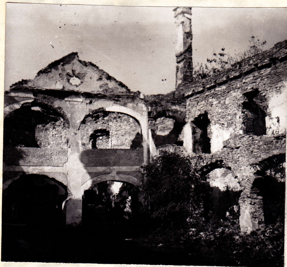
Unutrašnjost dvorca - ošte- ćenja.
